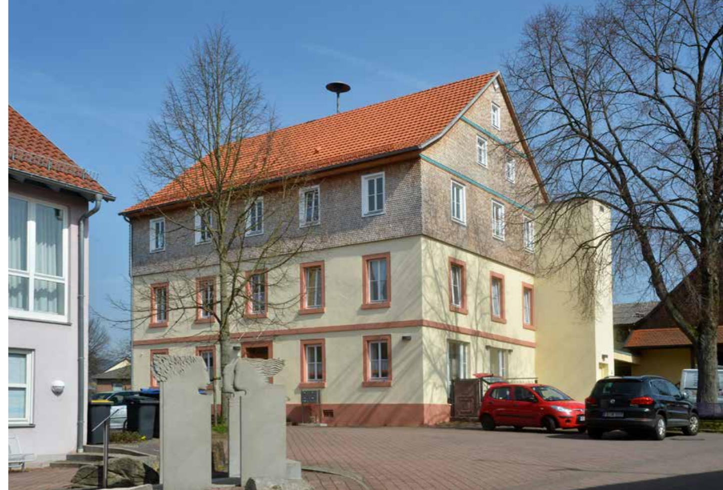
Nicht am Rand, sondern im Herzen der Dorfes: die von der Gemeinde bereitgestellte Immobilie für das Projekt „Leben und Arbeiten in Poppenhausen“
